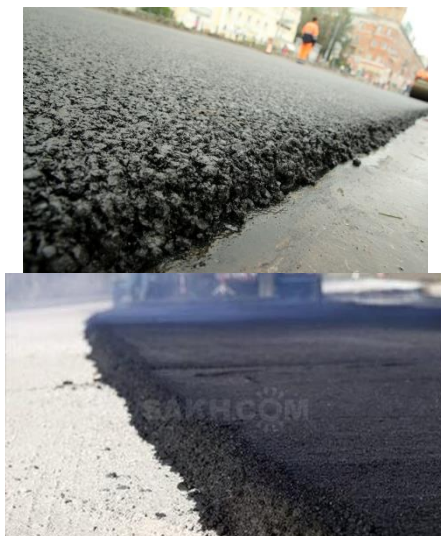
Рис. 1. Сравнение структуры щебёночно-мастичной смеси и асфальтобетонной смеси
