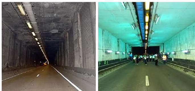
Рис. 2. Внутренний вид испытательного полигона в туннеле Леопольда II в Брюсселе до реконструкции и после реконструкции с использованием фотокаталитических материалов
